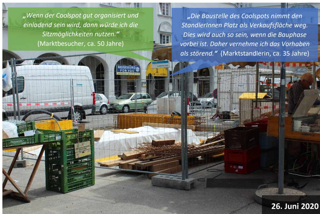
Abbildung 32: Baustellenstatus und Rückmeldungen am Schlingermarkt am 26. Juni 2020 (Quelle: Eigene Aufnahme)
