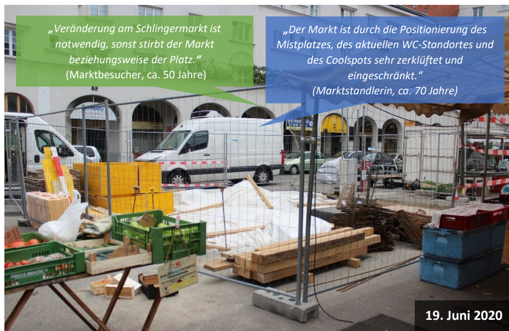
Abbildung 31: Baustellenstatus und Rückmeldungen am Schlingermarkt am 19. Juni 2020 (Quelle: Eigene Aufnahme)
