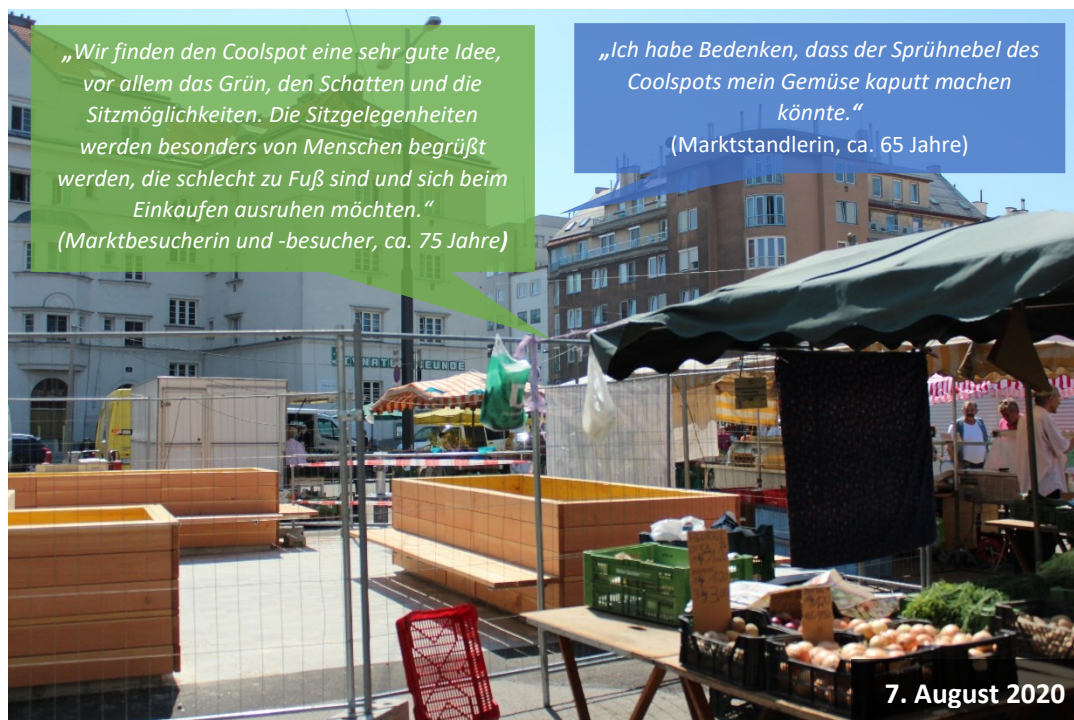
Abbildung 34: Baustellenstatus und Rückmeldungen am Schlingermarkt am 7. August 2020 (Quelle: Eigene Aufnahme)
