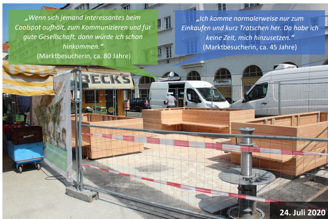
Abbildung 33: Baustellenstatus und Rückmeldungen am Schlingermarkt am 24. Juli 2020 (Quelle: Eigene Aufnahme)
