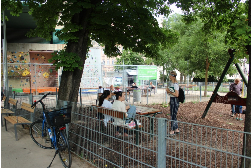
Abbildung 5: Gespräch mit Besucherinnen im Esterházypark während der Bauarbeiten, 1. Juli 2020 (Quelle: eigene Aufnahme)
